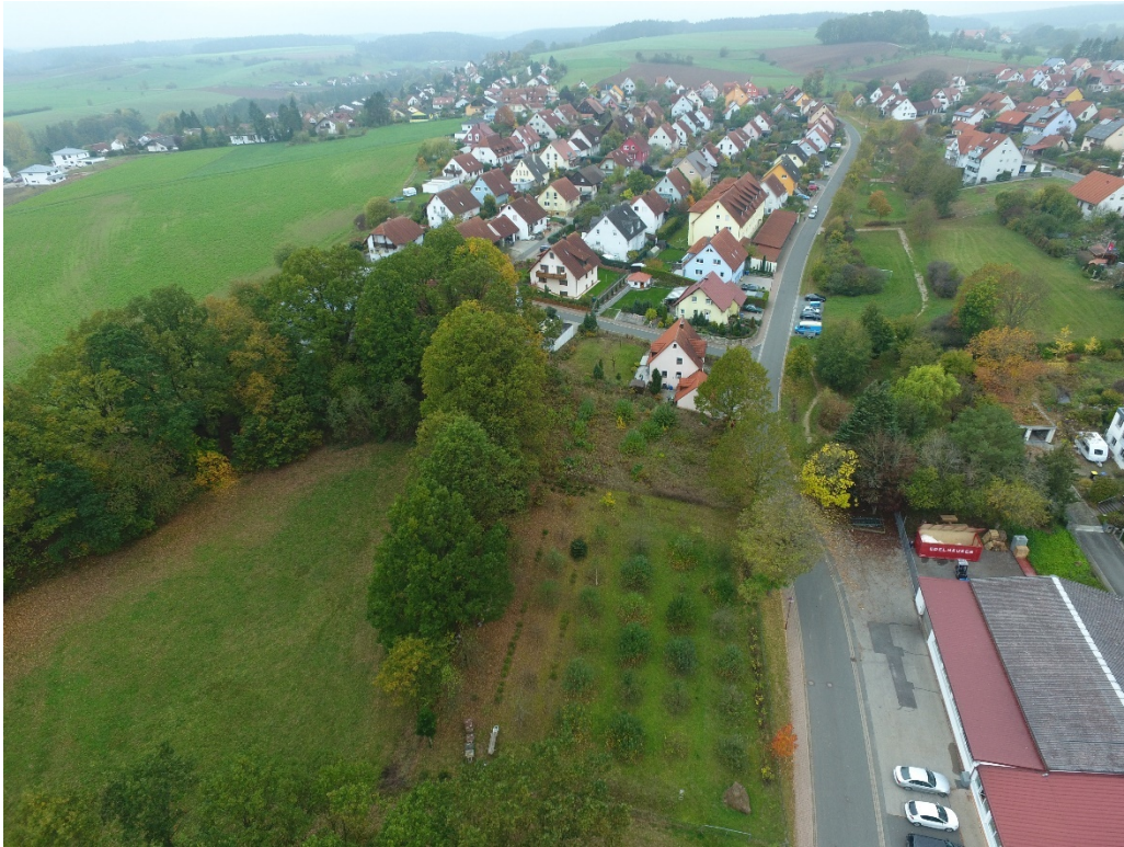
Abb. 5: Ansicht von Osten – Planungsfläche und Ziegelhüttenweg; Drohnenfoto Erl GmbH (Aug. 2021)
