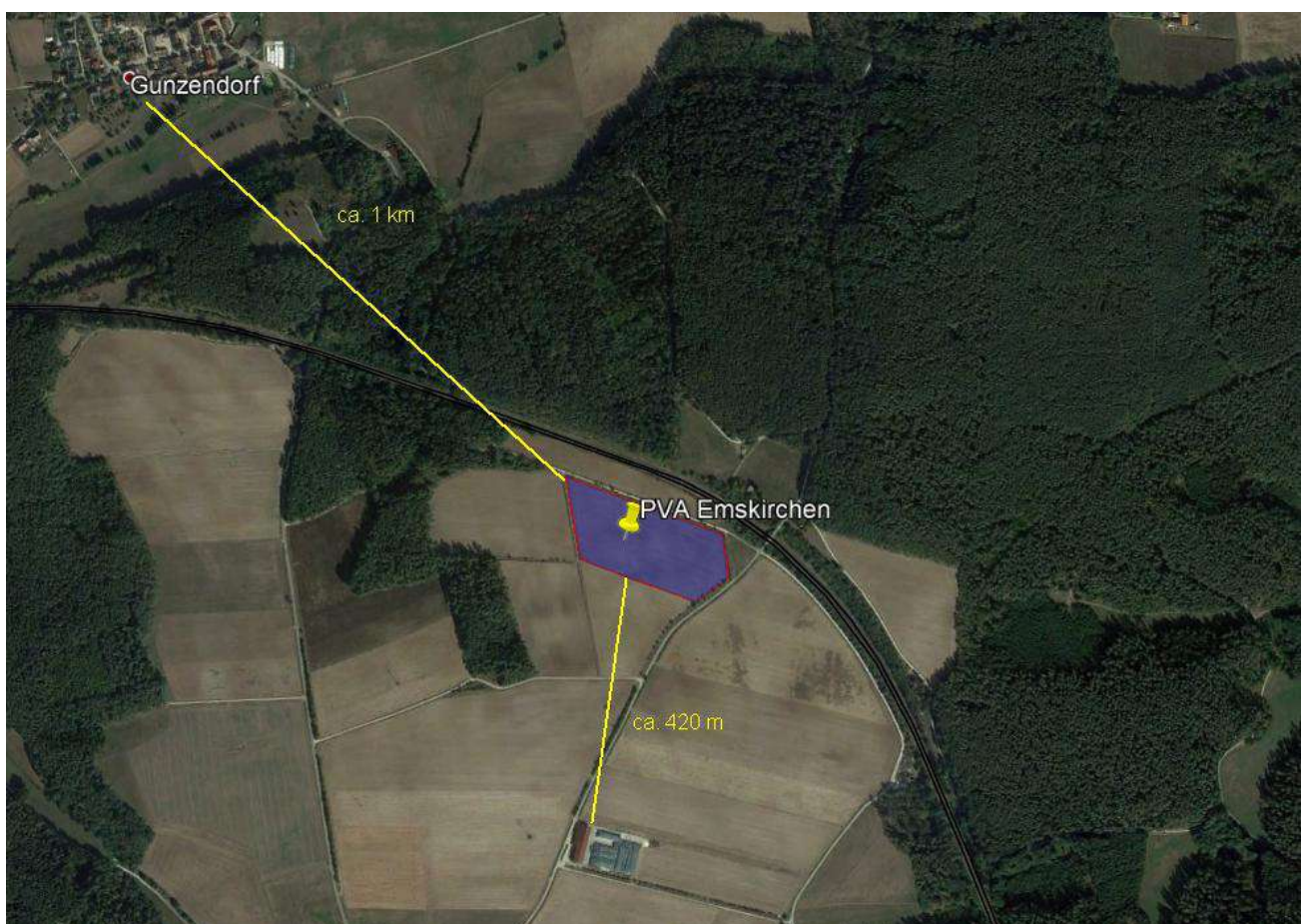
Bild 2.2.1: Gebäude nördlich der PV Anlage (Quelle: Google Earth/SolPEG)
